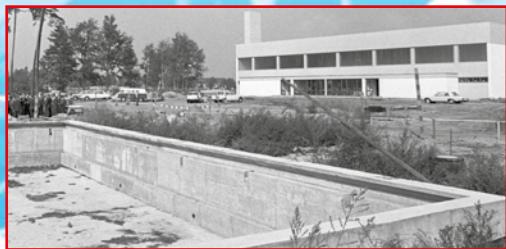
September 1967 in der NN Einsam und tröstlos der Anblick, neben der neuen Sporthalle entsteht das neue Clubbad
