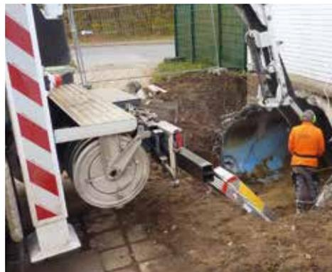
*Zur Orientierung: bei der Parkplatz-Ausfahrt wurde von außerhalb des Badegeländes die Filteranlage zunächst aufgebrochen und der Filtersand abgesaugt bevor die Abbruchspezialisten ganze Arbeit leisten konnten.*
