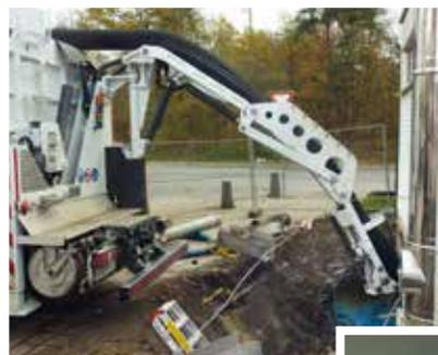
*Einige Tonnen alter Filtersand wurden von einem Spezialfahrzeug abgesaugt und entsorgt.*
