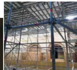
Während der Umbauzeit
